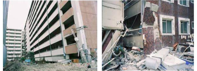
※写真の出典:国土交通省「マンション耐震化マニュアル」
