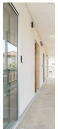
廊下側は掃き出しの開口部と耐力壁をメリハリよく配置し、長辺方向の耐震要素を確保しつつ室内に光を取り込んでいる。
