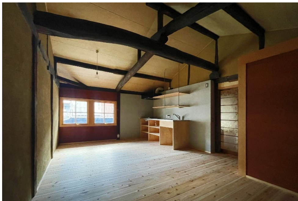
告示仕様の木製防火窓を制作し、修景と防火性能を両立。左手は補修した既存土壁。
