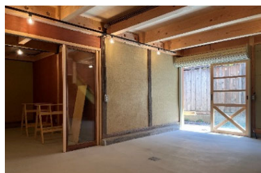
農業用シャッターを防火仕様に 改造。
