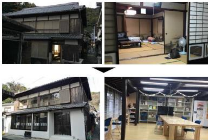
地域活性化のため空き家を地域交流施設に利活用
