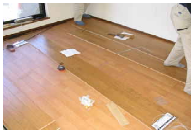
写真1-15 床暖房（木質系フローリング）施工状況
