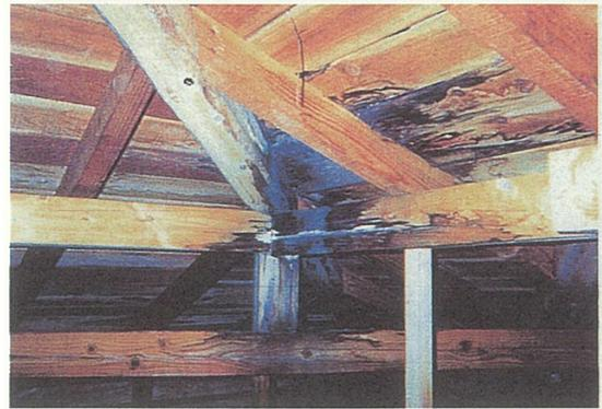
小屋裏の雨漏り部分の腐朽
