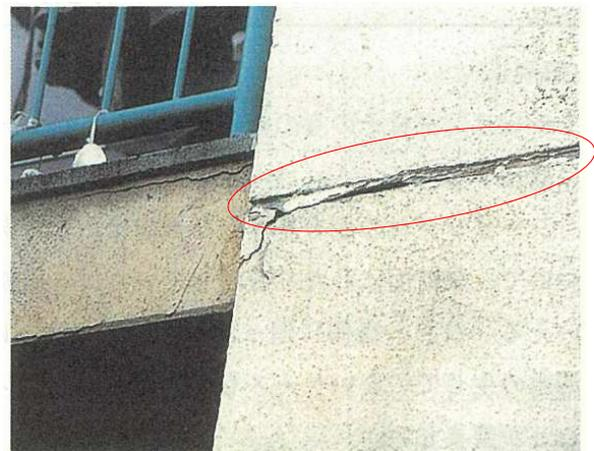
シーリング材の接着破壊
