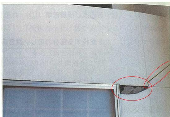
モルタルの「著しいひび割れ・欠損」
