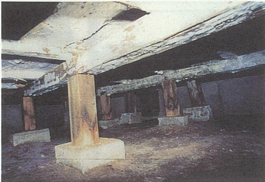
床下部分の腐朽
