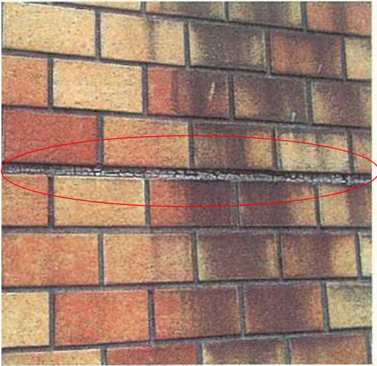
シーリング材の破断
