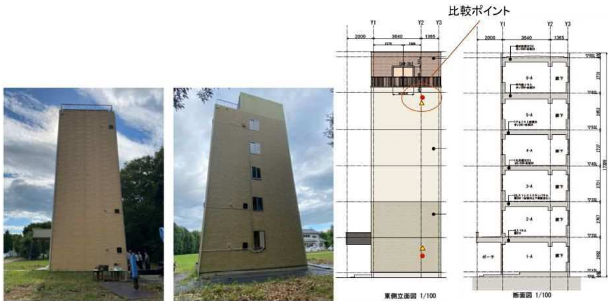
写真 4.2.1 実験棟（左：東面、右：北面）
