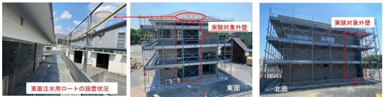
写真 3.1.1 実大モデル住宅の測定対象外壁と注水用漏斗（撮影：2021年）
