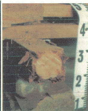
大引きの褐色腐朽
