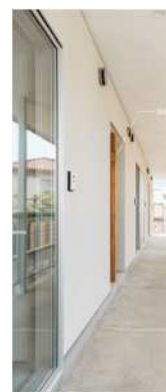
廊下側は掃き出しの開口部と耐力壁をメリハリよく配置し、長辺方向の耐震要素を確保しつつ室内に光を取り込んでいる。
