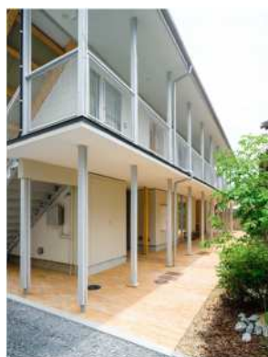
廊下側は掃き出しの開口部と耐力壁をメリハリよく配置し、長辺方向の耐震要素を確保しつつ室内に光を取り込んでいる。
