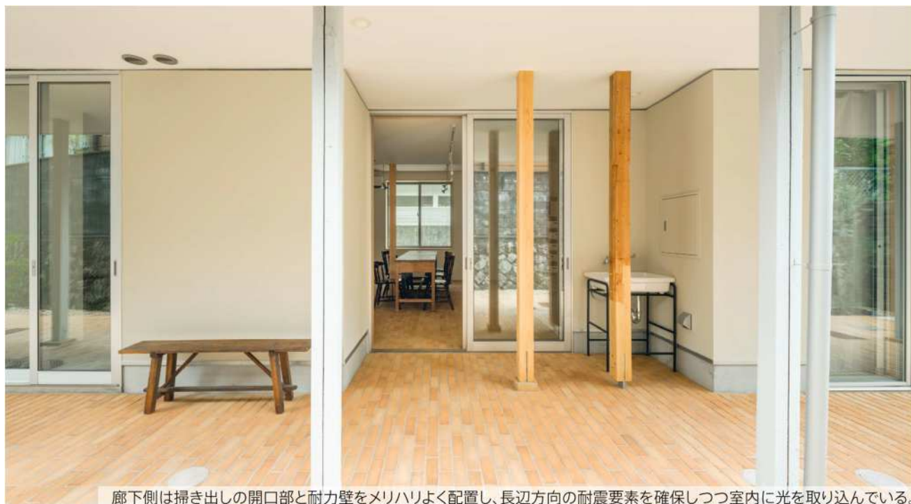
廊下側は掃き出しの開口部と耐力壁をメリハリよく配置し、長辺方向の耐震要素を確保しつつ室内に光を取り込んでいる。
